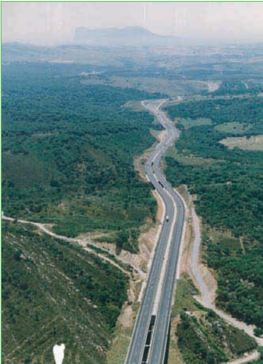
Foto 13. En la A-381 la compensación de tierras era uno de los objetivos prioritarios. Cuando el balance de tierras estaba descompensado se ha realizado la estabilización con cal de suelos arcillosos y de baja calidad, con un total de casi 4,5 millones de m 3 estabilizados.
