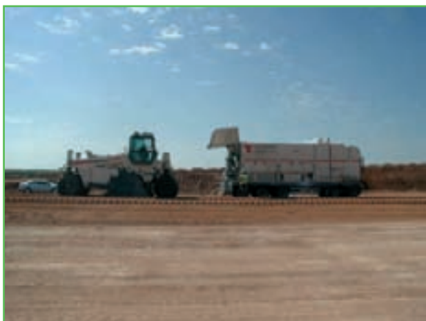
Foto 6. Estabilización de suelos in situ .
