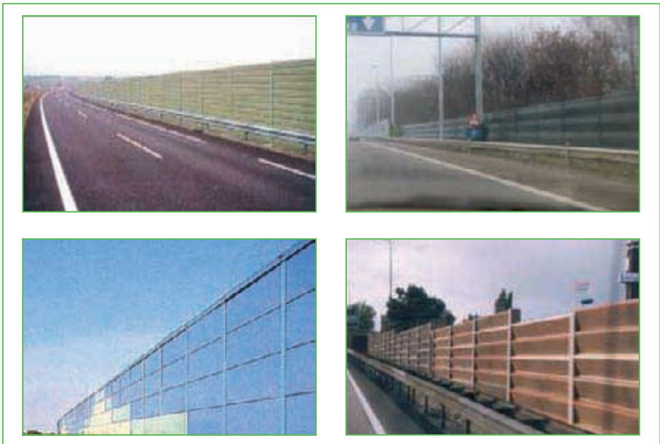
Foto 5. Ejemplos de pantallas realizadas con módulos metálicos, tipo "sandwich" (1)
