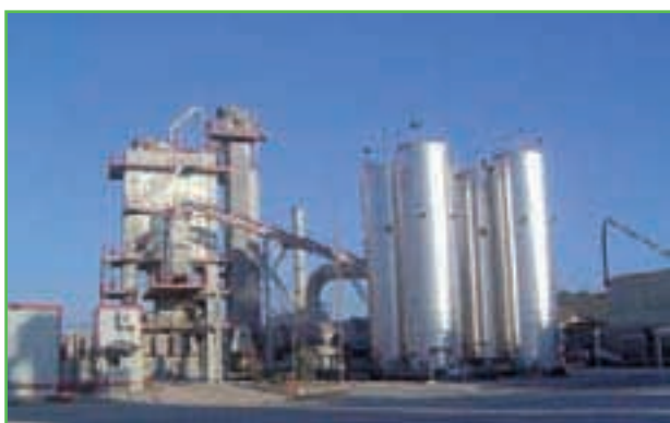
Foto 2. En el subsistema 2 se distingue el tipo de planta asfáltica que se va a emplear en el análisis
