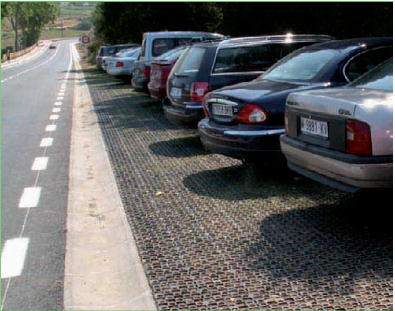
Foto 2. Colocación del pavimento drenante ecológico ATLANTIS para minimizar el impacto sobre la infiltración y el ciclo hidrológico local del entorno de la carretera.
