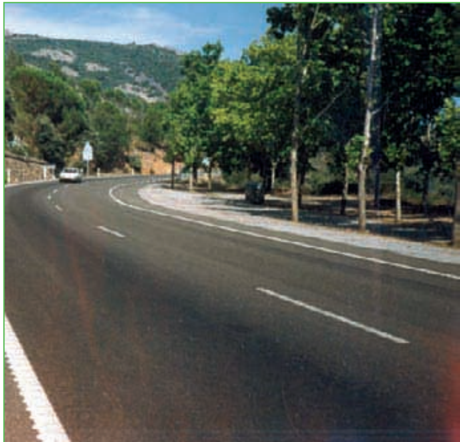
Foto 1. La construcción de infraestructuras viarias en zonas protegidas y de alto valor ecológico plantea una problemática específica que exige, entre otras cuestiones, su óptima integración.
