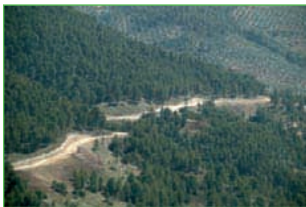
Foto 5. En el diseño del trazado de las vías (aquí el de Ballestera) debe buscarse el ajuste de la carretera al territorio, y no al contrario, combinándose para ello la geometría, la pendiente, los radios de curvas, etc.
