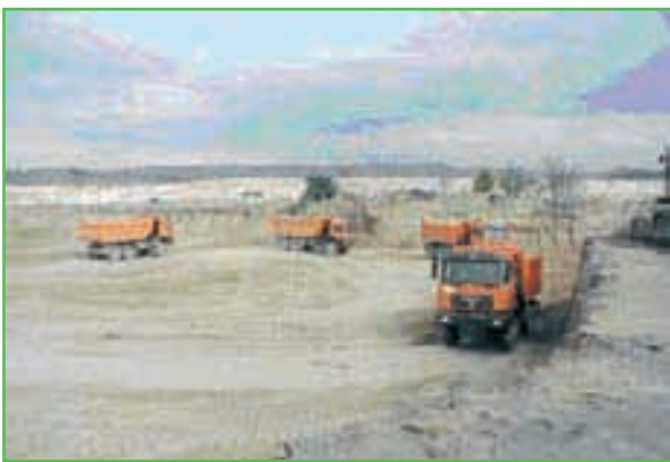
Foto 11. Transporte del movimiento de tierras.
