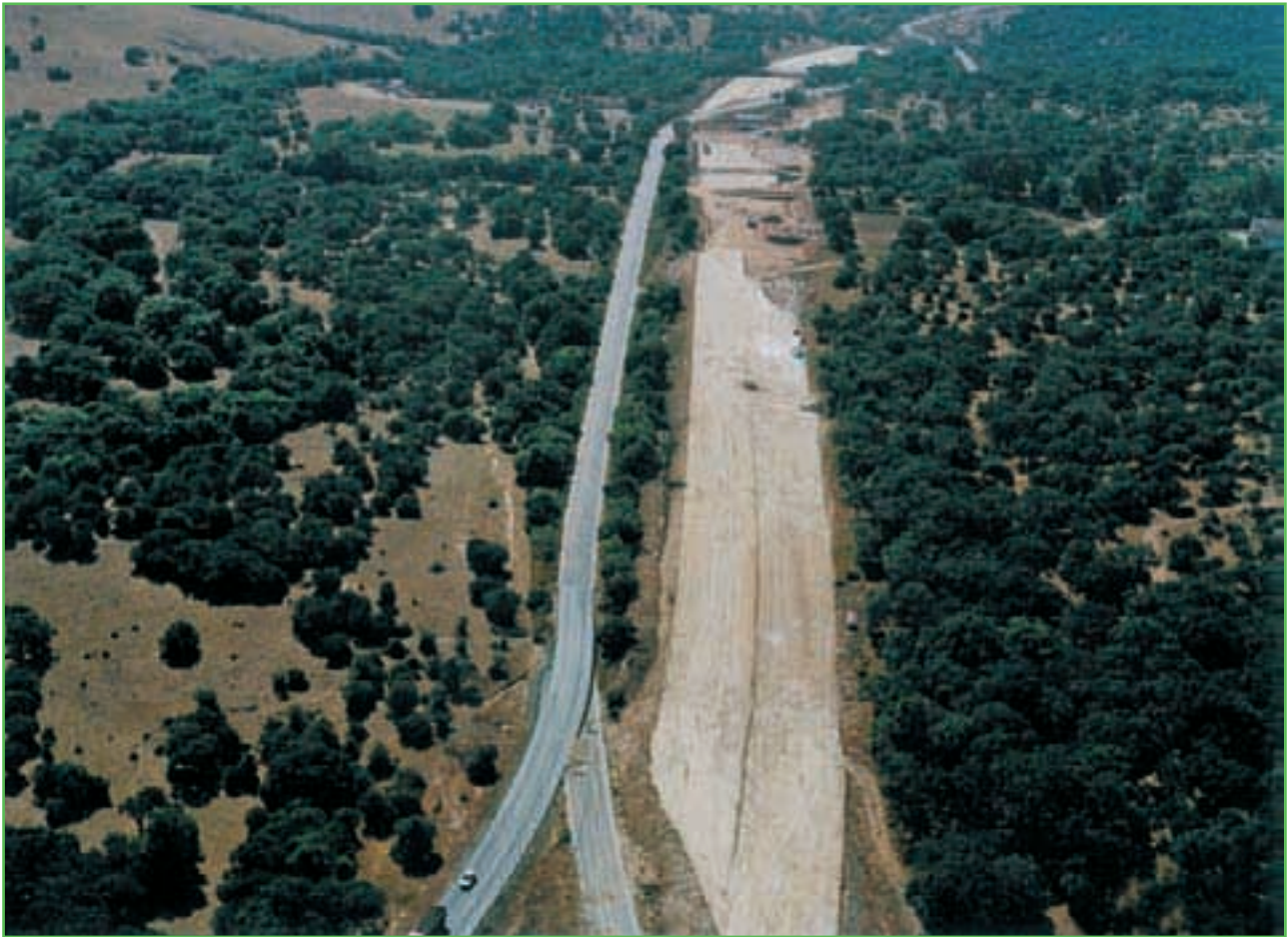
Foto 8. Vista aérea de las obras de la traza de la autovía A-381.
