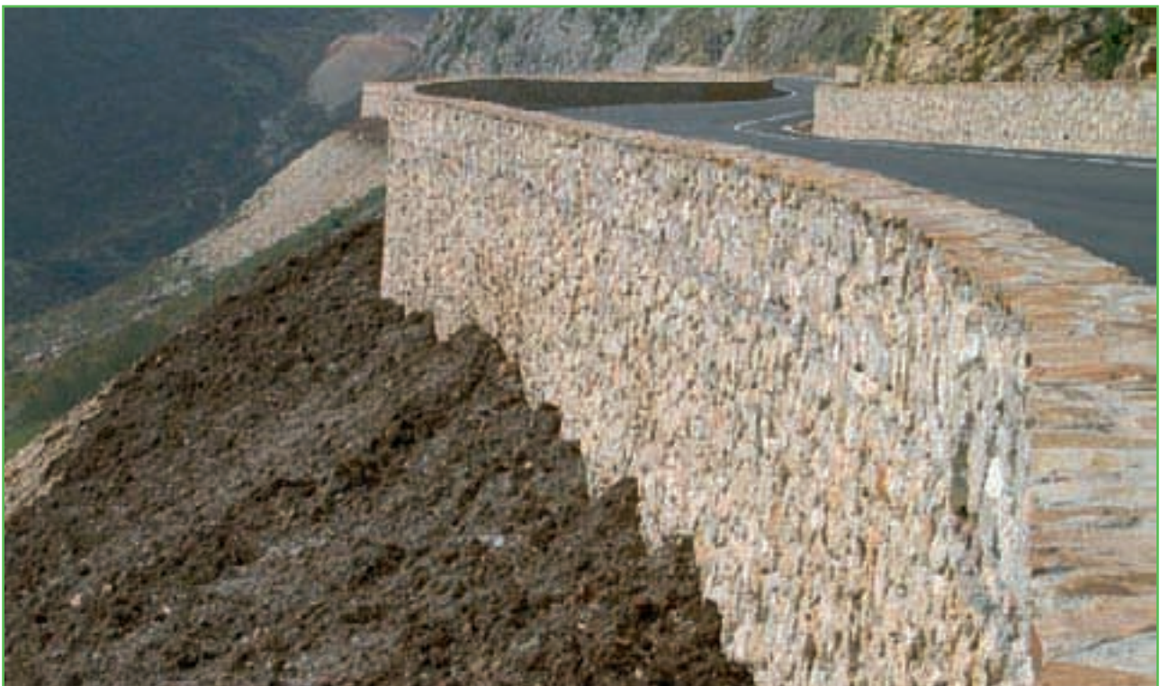
Foto 6. Como estructuras de contención deben usarse preferentemente soluciones integradas en el entorno, con empleo de materiales propios de la zona (vista de un muro en Ronda)
