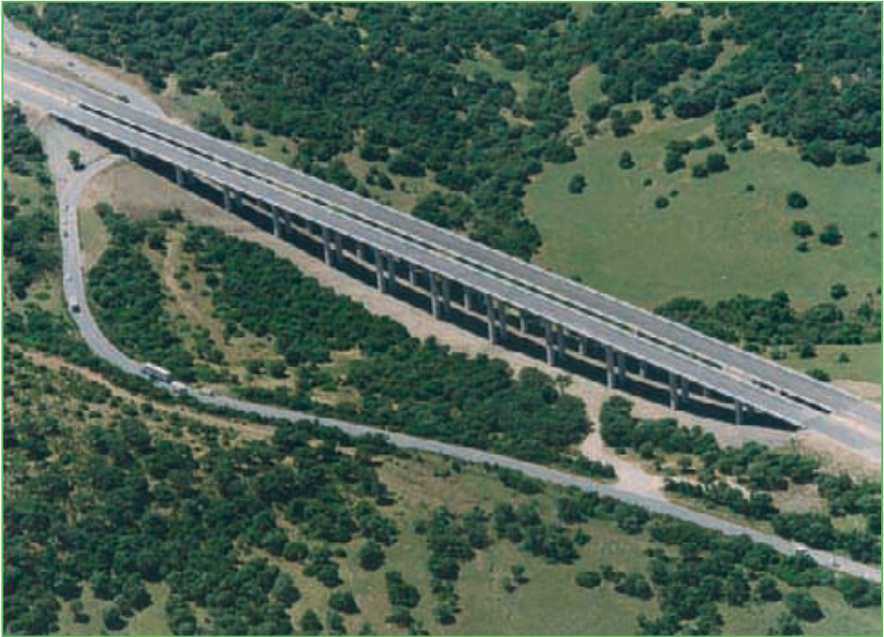
Foto 12. En la autovía A-381 se han dispuesto puentes y viaductos cuando los terraplenes del proyecto sobrepasan los 5 m de altura. Con esta medida se han realizado 24 viaductos, con una longitud total de 4.641 m.
